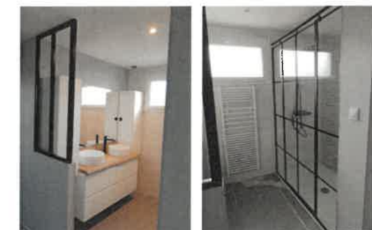
POSE DE VERRIÈRES
